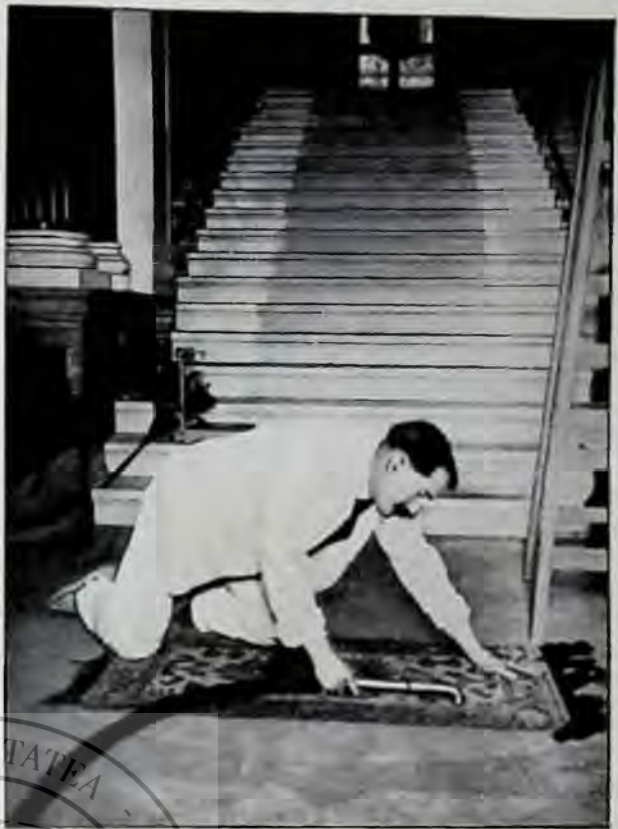
Fig. 9. — ASPIRATEUR DE POUSSIÈRES. L'aspiration des poussières, très supérieure, du point de vue hygiénique, au balayage, s'effectue, pour les grandes surfaces, à l'aide d'appareils importants. On ne voit ici que l'extrémité du tuyau aboutissant extérieurement au moteur et au récipient.
