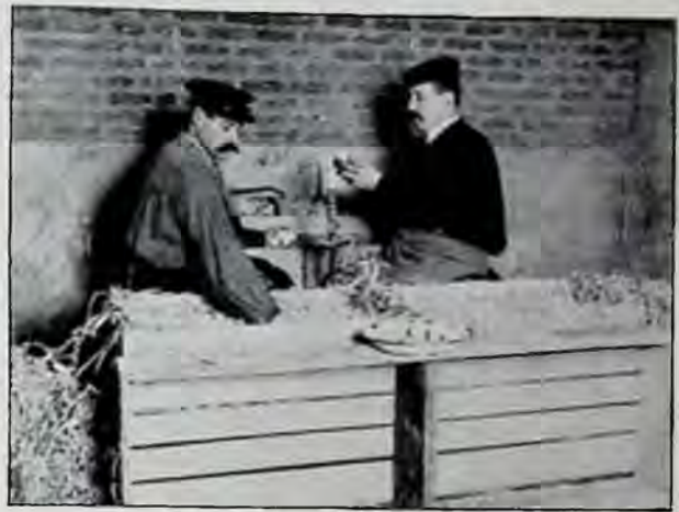
Fig. 7. — MIRAGE DES ŒUFS. Les mireurs-jurés des Halles apprécient le degré de fraîcheur des œufs par transparence devant une chandelle. Ils peuvent reconnaître ainsi le volume de la chambre à air qui se trouve à la grosse extrémité. (Cl. Boyer.)
