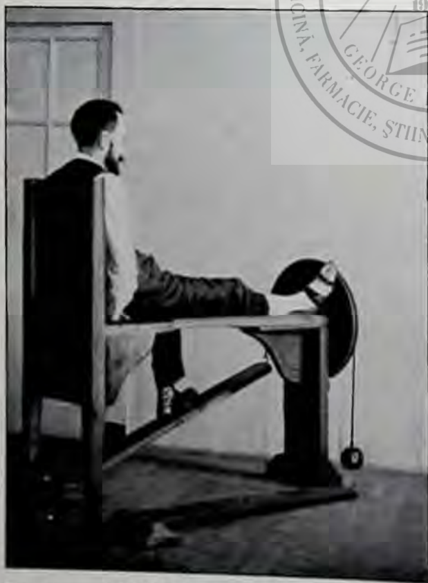
Fig. 14. — MÉCANOTHÉRAPIE ☼ La mécanothérapie peut être appliquée à l'aide des appareils les plus simples. Celui que l'on a représenté ici permet d'obliger le pied à faire des mouvements d'adduction et d'abduction. (Cl. Boyer.)
