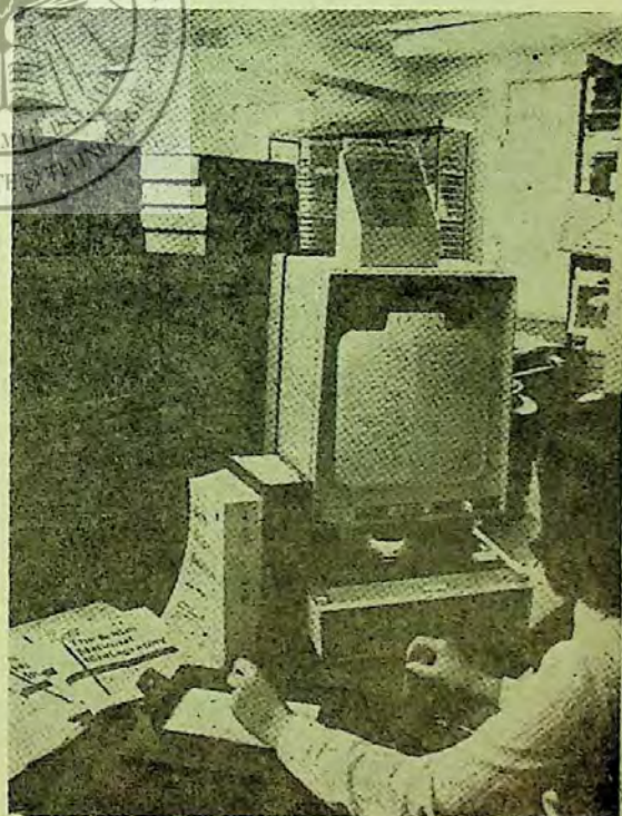
Aparat de construcție specială pentru citirea ultramicrofișelor.
