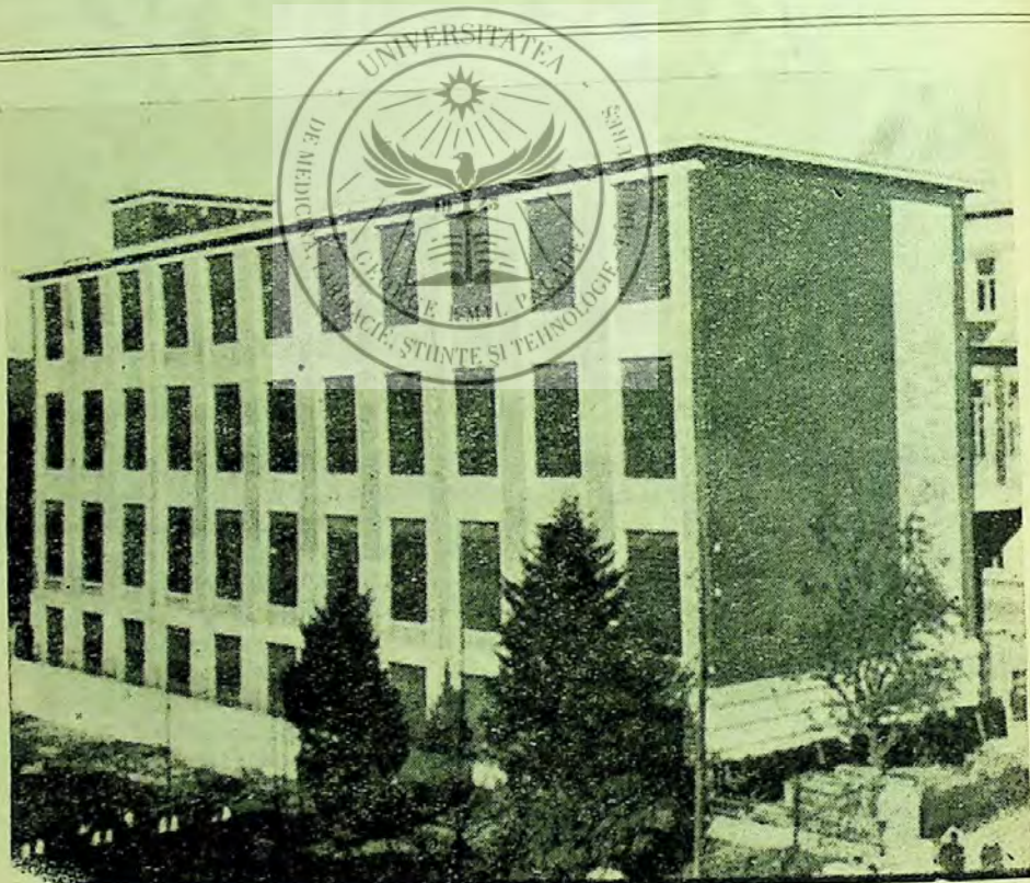
Noua aripă a Bibliotecii centrale universitare din Cluj, destinată pentru un depozit de cărți cu o capacitate de cca. 2 milioane volume. Clădirea are 8 paliere cu 36.000 m. liniari de rafturi.
