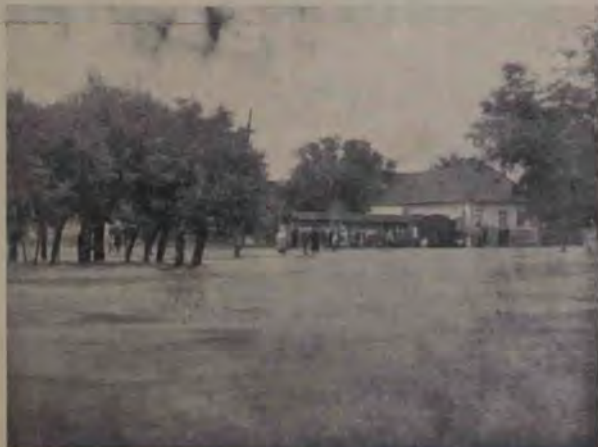
Strada Fabricii din Orăștie sub apă.
